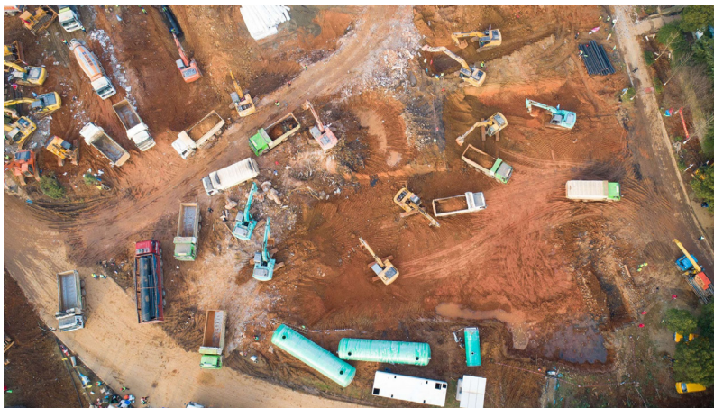
複製「小湯山模式」開工建設的火神山醫院施工現場。（新華社）
